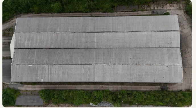
Üstten görünüm: geniş çatı yüzeyi (GES potansiyeli).
