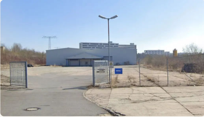
Saha girişi ve kontrollü kapı.
