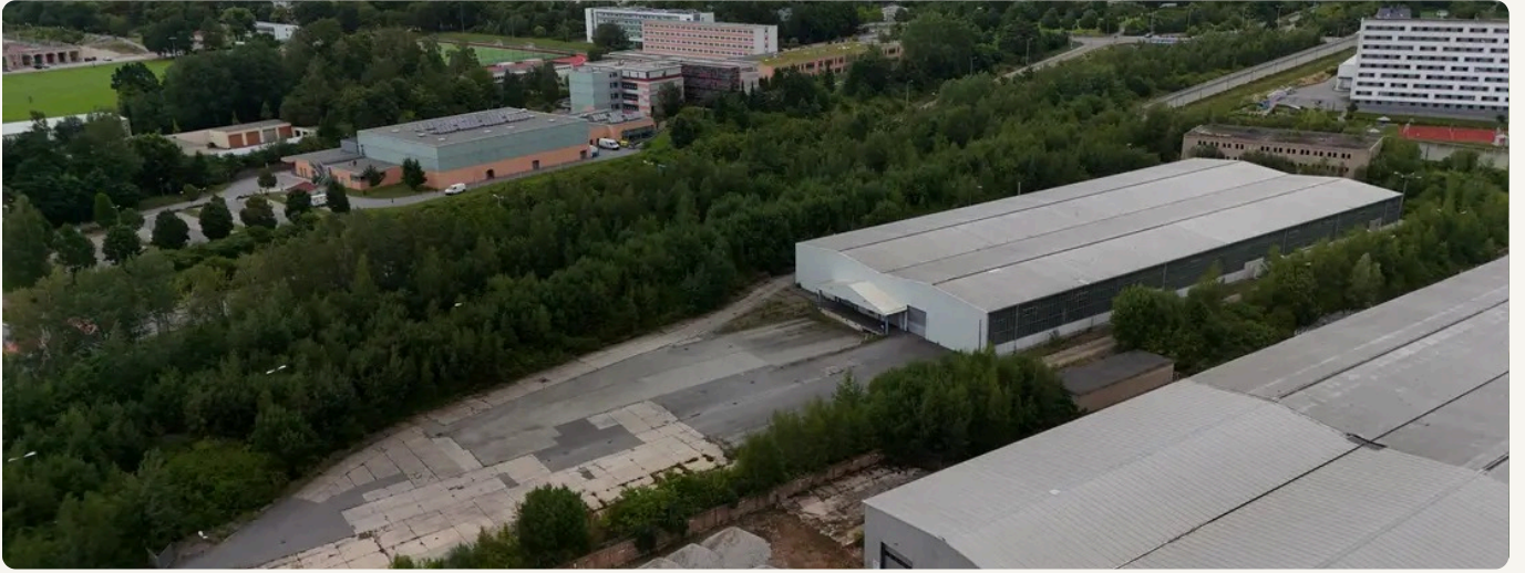
Kuş bakışı: tesis yapıları, beton açık saha ve arka planda Chemnitz şehir dokusu.
