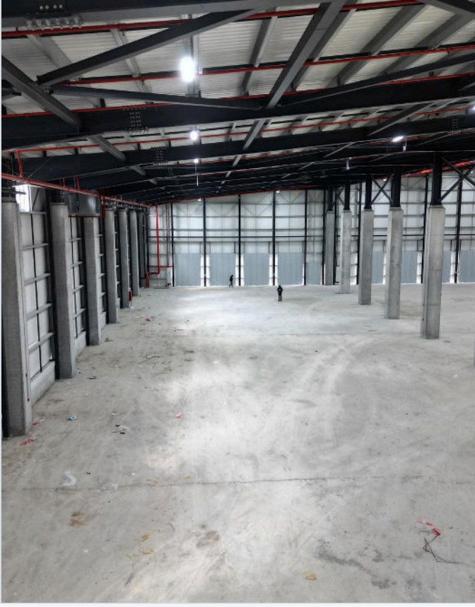
Üst kat — çelik çatı, sprinkler hattı
