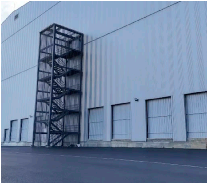
Seksiyonel rampa cephesi ve asfalt manevra alanı
